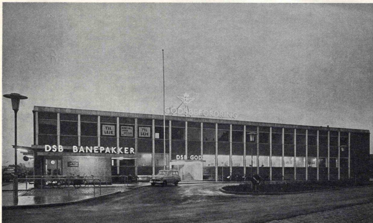
Fig. 7. Den nye ekspeditionsbygningens facade mod Jyllandsgade.
