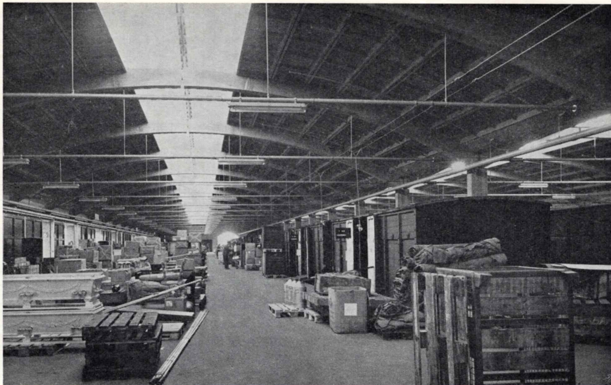
Fig. 10. Pakhushallens midterste fløj. Man ser mod syd ned over den 9 m brede perron.
