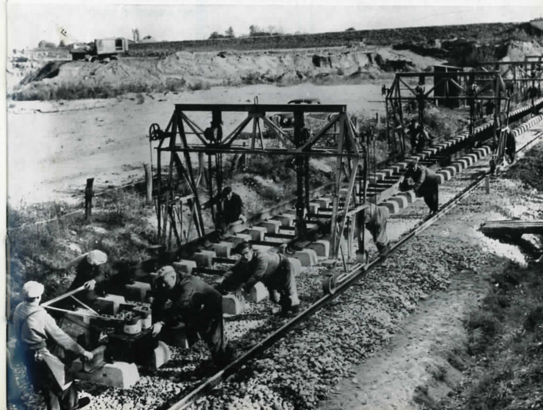
Modernisering af en sporstrækning sker som regel nu ved, at skinnerne monteres på betonsveller forinden udlægningen.
