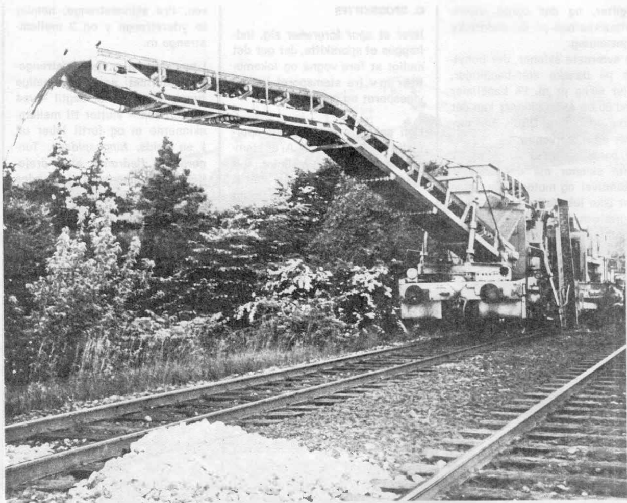
Moderne ballastrensningsmaskine i arbejde.
