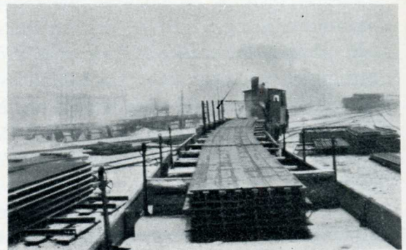
Fig. 93. Transport af 30 m lange Skinner. Skinnerne bøjer sig efter Sporets Kurver.
