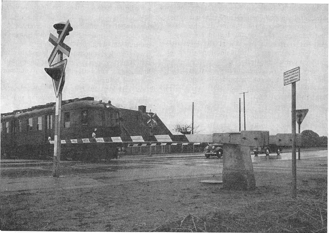
Fig 70. Bomme i nedlukket stilling. Højre kørebaner spærret.
