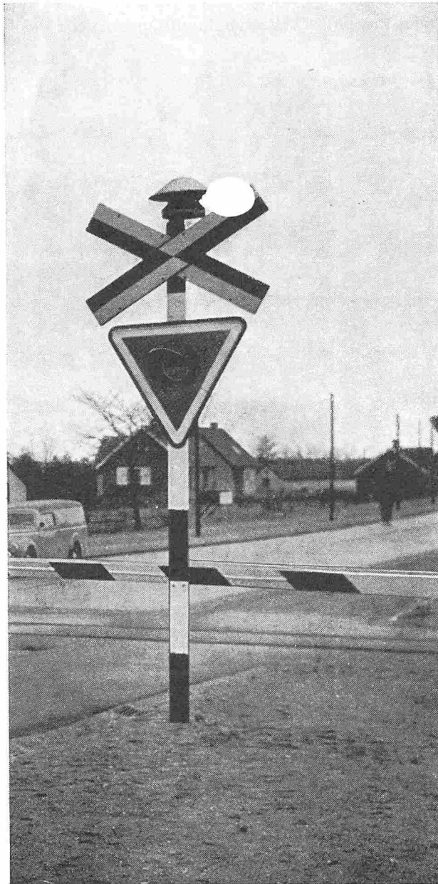
Fig 69. Vejsignal i højre vejside med klokke og kryds.
