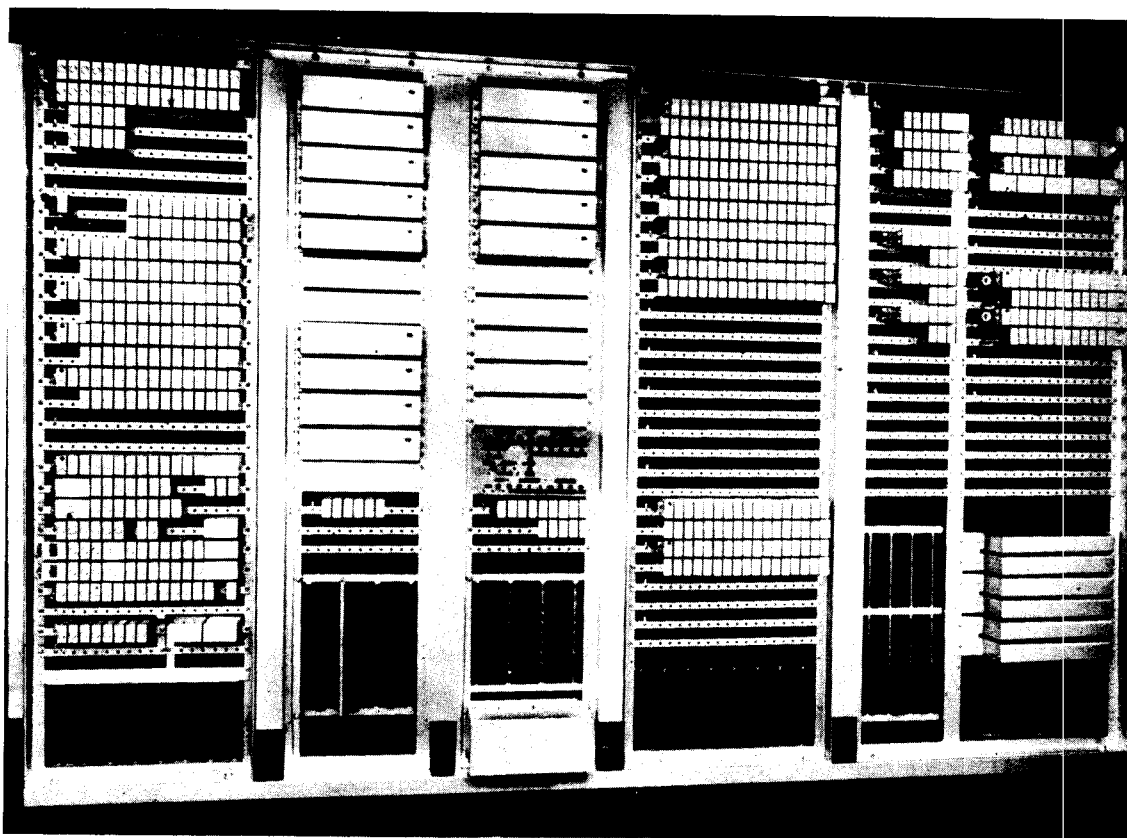
Knudepunktcentralen i Nykøbing Fl. Til venstre Relæstativ, i Midten Vælgere. Nederst til højre Overdragere til Strækningsledninger.
