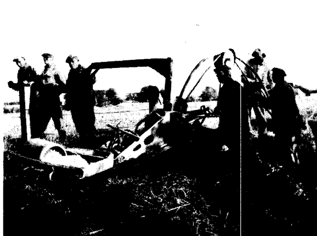
Fig. 8. Kabelplov i arbejde.
