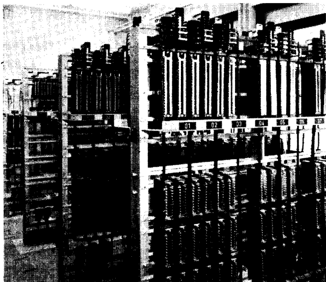
Fig. 18. Relærummet for sikringsanlægget i Rødby F. Relæstationerne er leveret færdigmonteret fra DSL.
