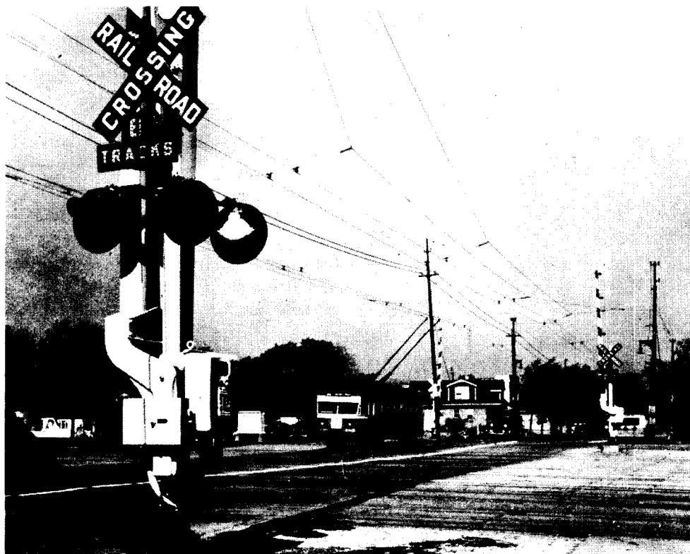
Fig. 14. Advarselssignalanlæg kombineret med automatiske bomme.
