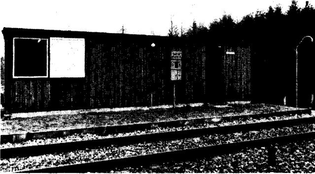
Fig. 16. Relæhus med tilhørende stationskontor på en fjernstyret station på Lolland. Ved døren ses skabet omtalt under fig. 17.
