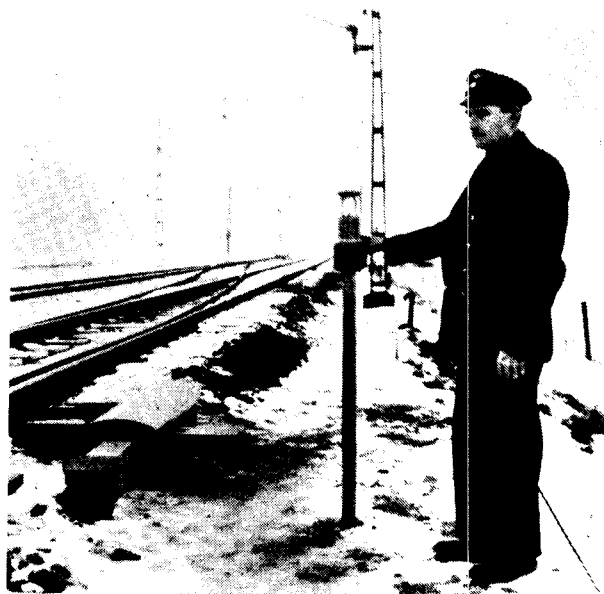
Fig. 2. Stedbetjeningskontakt for omstilling af sporskifter. Øverst ses lanteren.
