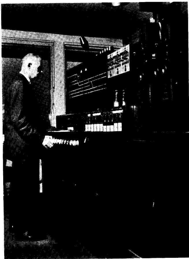
Fig. 5. Det elektromekaniske centralapparat i Valby udført af LME og DSI i 1940/41. Anlægget var et af de første, der udførtes med strømskemaer efter DSB-standard.
