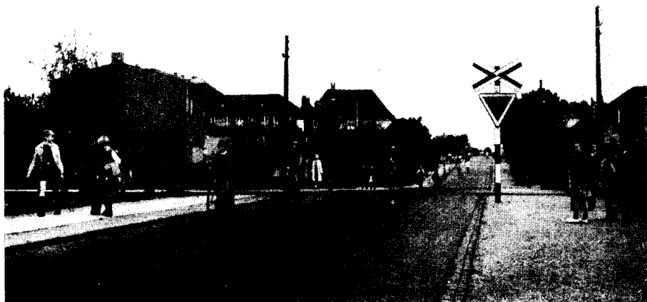
Fig. 1. Advarselssignalanlægget ved Dyssegårdsvej, København. Anlægget er ikke forsynet med klokker trods den megen færdsel af skolesøgende børn.
