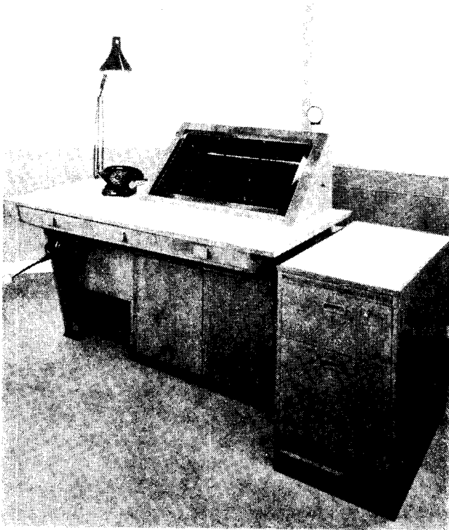
Fig. 22. Central-apparat for Frederik d. 1X's bro. Højre del af tavlen indeholder manøvreringsknapper for advarsels- og bomanlæg, sportungebevægelser, forrigling m. v. Øverste venstre del indeholder manøvreringsknapper for broklapperne. Nederste venstre del indeholder knapper for styring af bromaskineri under nøddrift.
