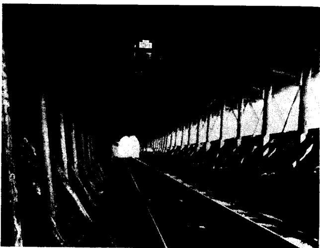
Fig. 4: Snetunnel på højfjeldsstrækning. Om sommeren er en del af sidevæggene fjernet af hensyn til udsigten.
