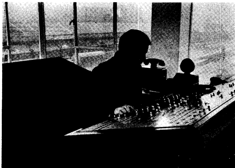
Fig. 3. Centralapparater og telefonbord for overportør. Til højre for telefonapparatet ses samtaleanlægget for forbindelsen til relærummet.
