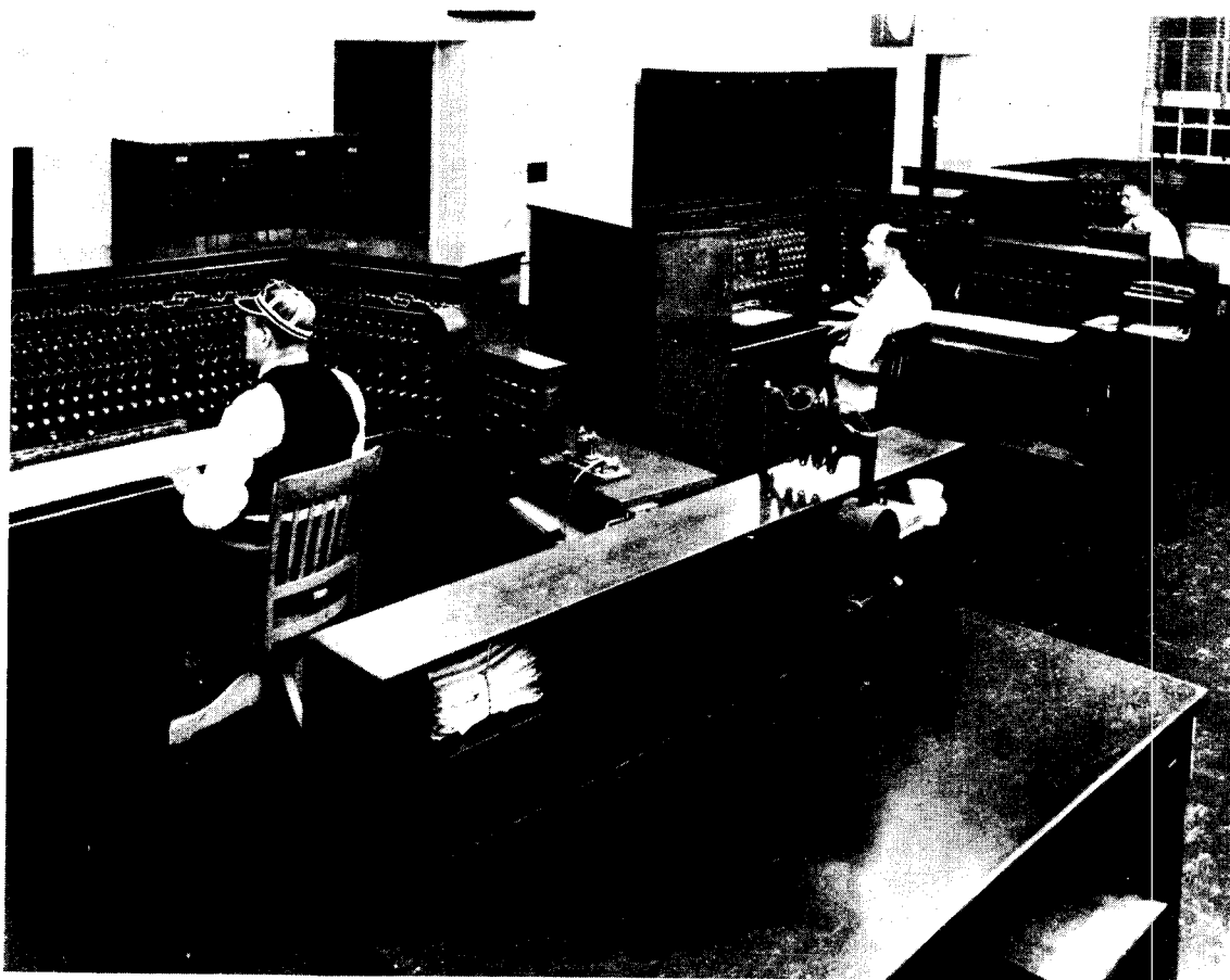
Fig. 1. Tre fjernbetjeningsapparater (CTC anlæg), der betjener sporskifter og signaler på flere 100 km strækning.
