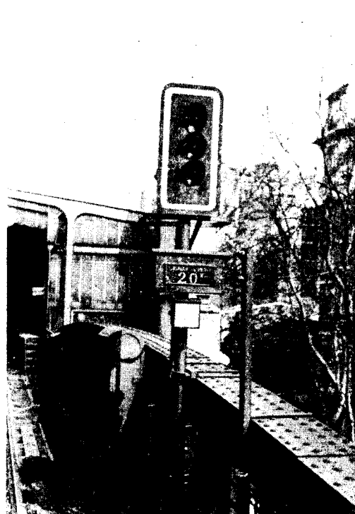
Bild 20. Trefärgssignal. Paris Metro (viaduktbanan). Signalbilderna äro vitt för klart, grönt för varsamhet och rött för stopp.
