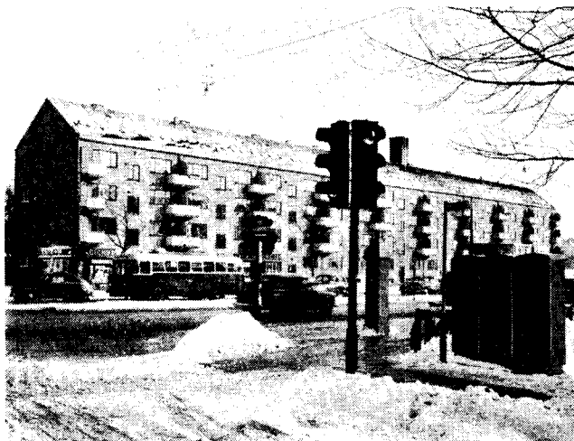
Fig. 3: Anlæggets forstærkere og relæer er monterede i tre vandtøtte skabe af letmetal. Fra venstre ses manøvreskab, relæskab og forstærkerskab. Der er anbragt standsignaler, dels for fodgængere og dels for den kørende trafik.
