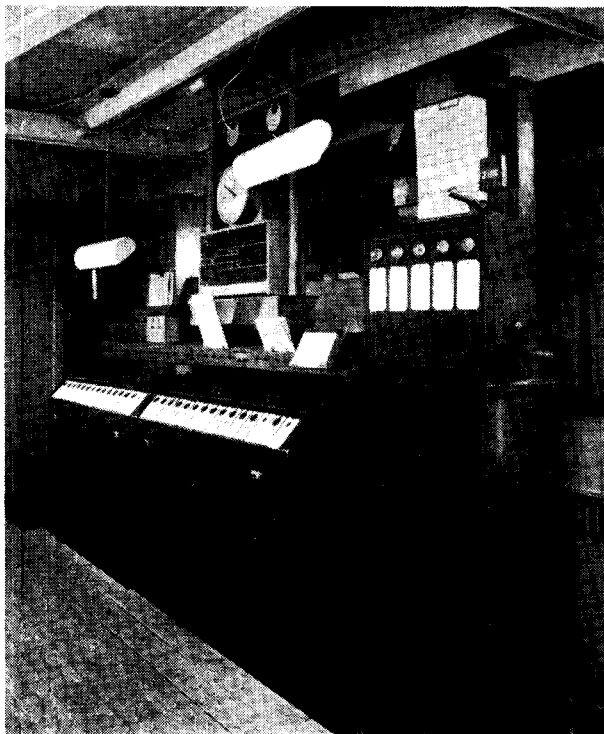
Det gamle centralapparat og blokapparat fra post 6, København H.
