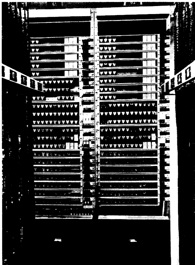
Fig. 2. Relæstativ til understation for traditionel relæfjernstyrings-system.
