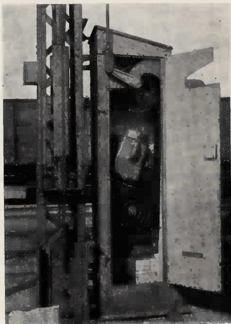
Fig. 184. Signaldrev, ældre Type (Siemens & Halske).
