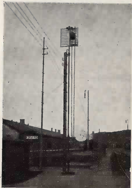
Fig. 28 a. Rangesignal med Skive.
