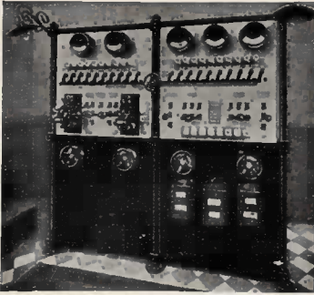
Fig. 170 a. Ladetavle for et elektrisk Sikringsanlæg.
