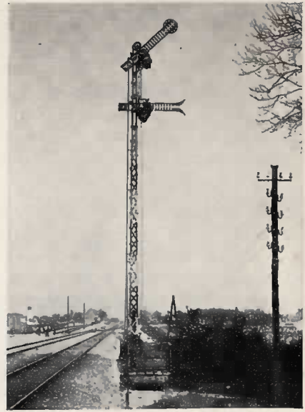
Fig. 14. Indkørselssignal (»Kør frem«).
