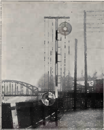
Fig. 5. Mastesignal ved Billetsalgssteder og Holdepladser uden Sidespor.
