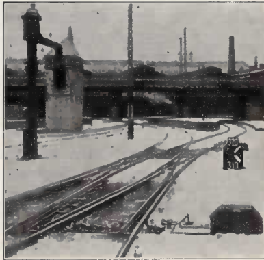
Fig. 37 b. Krydsningssporskiftet stillet til Kørsel i krumt Spor til højre.
