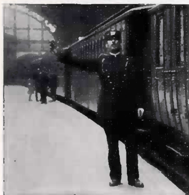
Med front mod lokomotivet udstrækker togføreren den ene arm vandret og fløjter en lang og een eller flere korte toner.
