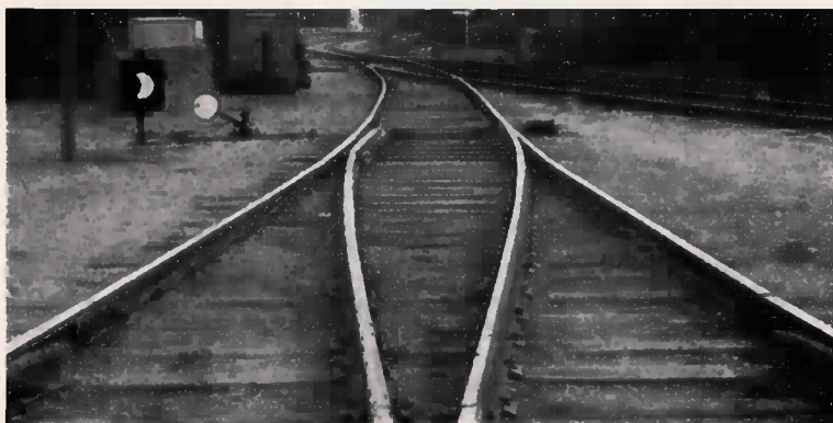
Halvmåneformet, hvid flade, hvis krumning angiver afvigelsens retning.
