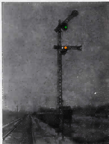
Et grønt, fast lys lodret over et brandgult, fast lys .
