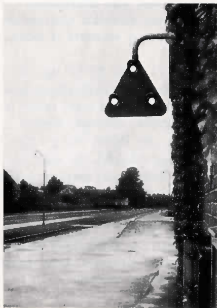
Tre hvide lys i trekant på trekantet baggrundsplade.
