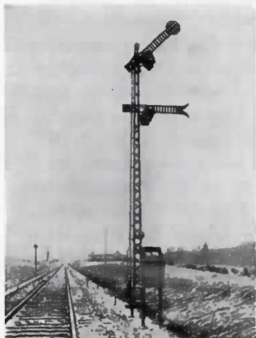
Øverste arm skråt op ad , nederste arm vandret .
