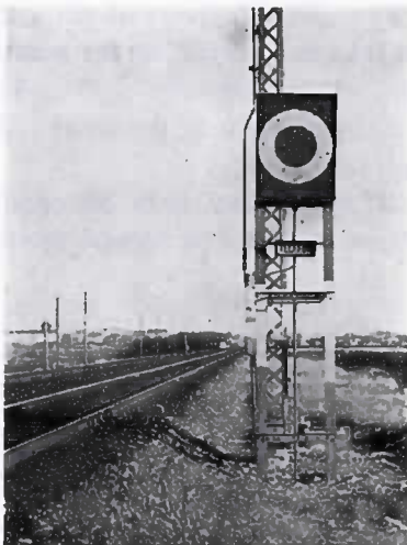
Hvid ring anbragt på signalets forside.
