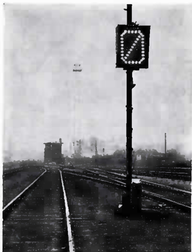
Hvidt, lysende bogstav i forbindelse med en kørtilladelse fra det tilhørende signal.
