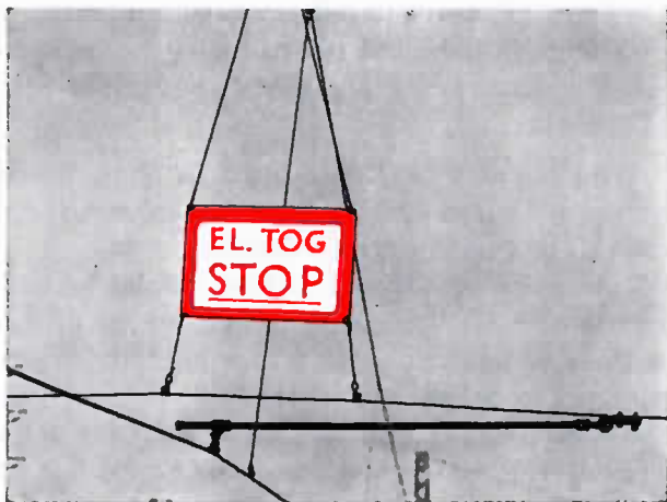
Rektangulær, hvid skive med rød kant og med påskrift »EL. TOG STOP« i røde bogstaver.
