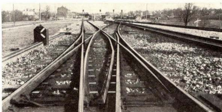
En vinkelformet, hvid Figur , der viser, til hvilket af de krumme Spor Krydsningssporskiftet er stillet.
