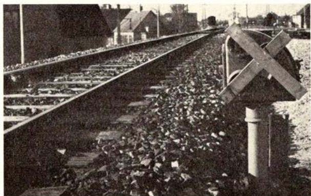
Et Kryds anbragt tværs over Dværghsignalet.
