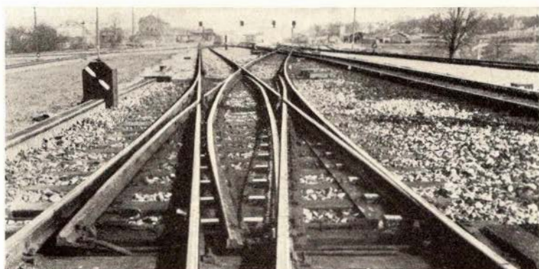
Skraa, hvid Stribe , der viser, til hvilket af de lige Spor Krydsningssporskiftet er stillet.
