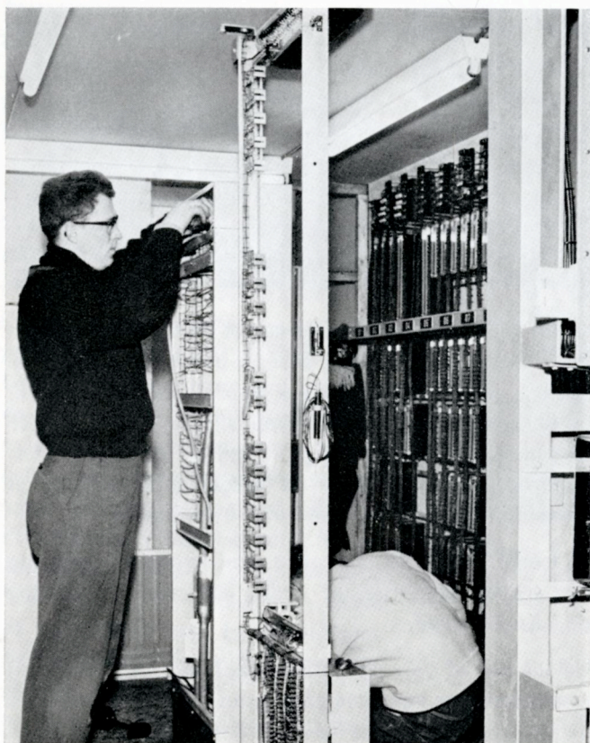
På billedet ses monteringen af sikringsanlægget til en af de 8 fjernstyrede krydsningsstationer på Fugleflugtslinien.
