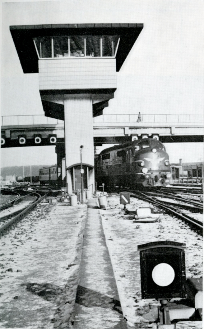
Underdelen af den nye signalpost på Nyborg station har på grund af det tætte sporet måttet gøres meget smal.
