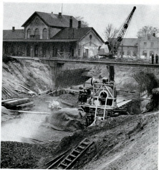
I forbindelse med udførelse af et underforingsanlæg til afløsning af niveauoverkørslen i sydenden af Vojens station foretages en ombygning af stationens sporanlæg m v, samt opføres en ny stationsbygning, rutebilholdeplads m m.
