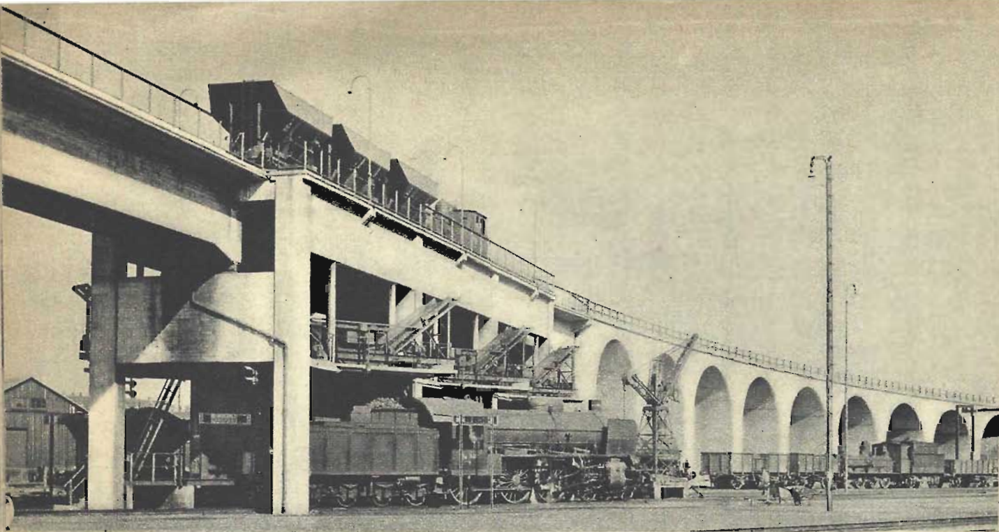
Kulforsyningsanlæg paa Københavns Godsbanegaard 1945.
