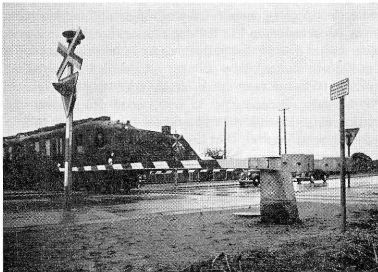
Fig. 72. Niveauekørsel med lyssignaler suppleret med automatiske halv-bomme og klokker.
