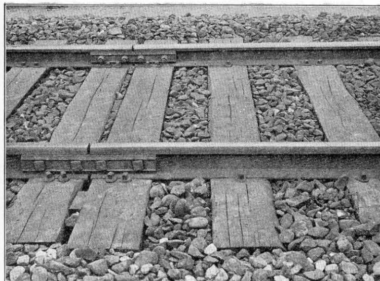
Fig. 25. Overbygning V Bt.
